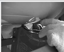
**P7.** Montar el estanque sobre la estructura de soporte y fijarlo con las tuercas.
